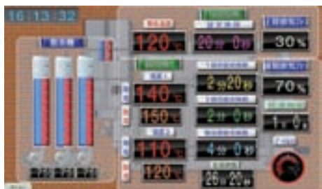
制御盤画面（FTDC-100）
